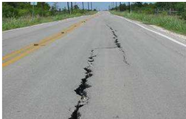
Fig1. Longitudinal cracking
